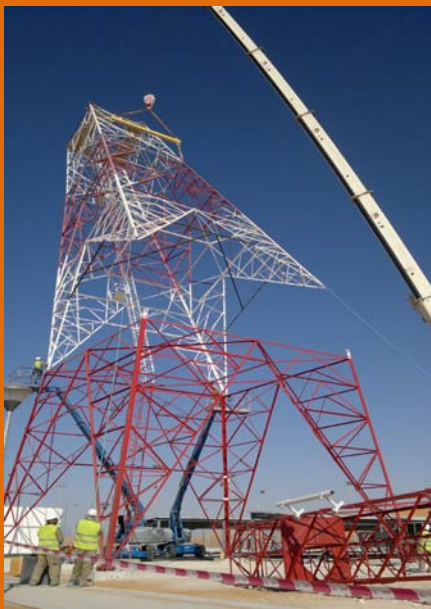
Réalisation des Antennes
