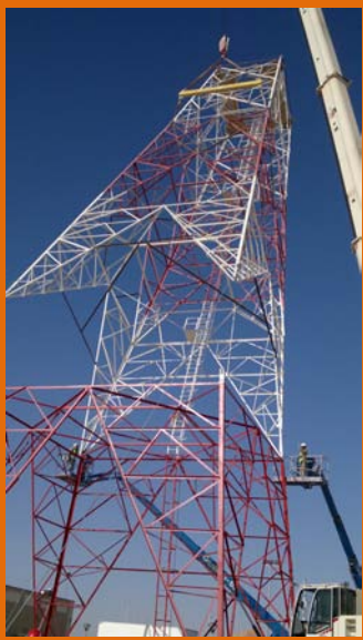
Réalisation Des Antennes
