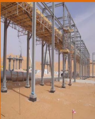
Réalisation Pipe Rack pour une raffinerie
