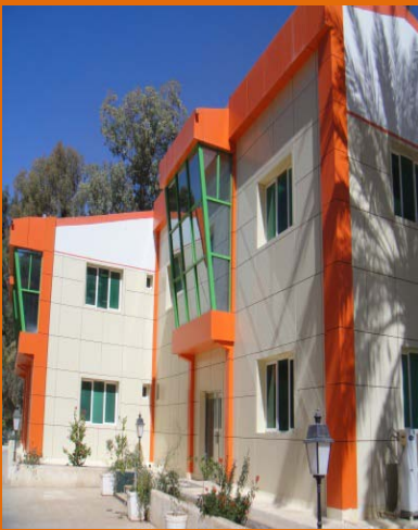
Réalisation d'un bloc Administratif en R+1
