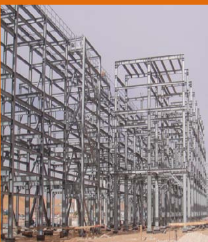
Réalisation du pipe rack pour une Raffinerie
