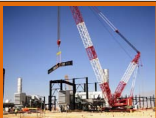
Montage Charpente métallique
