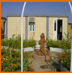
Réalisation d'un bloc Administratif R+0
