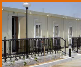
Réalisation blocs Administratif R+0
