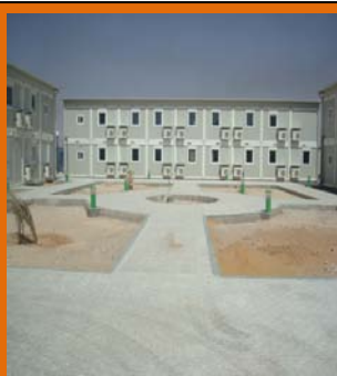
Réalisation bloc R+1 et aménagement extérieur
