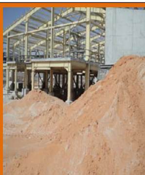
Fabrication et Montage Charpente métallique
