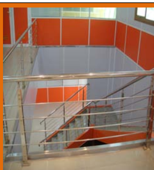
Réalisation blocs Administratif R+1
