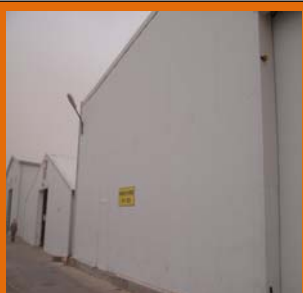
Réalisation hangar en charpente métallique
