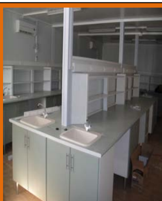
Réalisation bloc laboratoire
