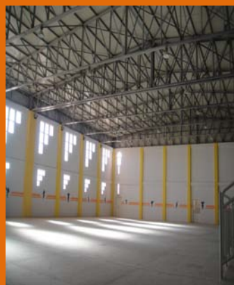
Réalisation Charpente métallique lourde
