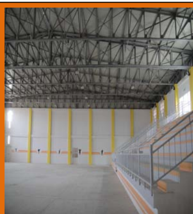
Réalisation salle de sport en charpente lourd
