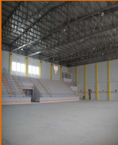
Réalisation d'une Salle de Sport de 500 Places
