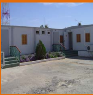
Réalisation d'un bloc Administratif R+0
