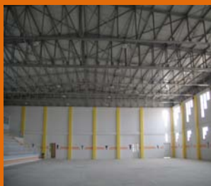
Réalisation Charpente lourd
