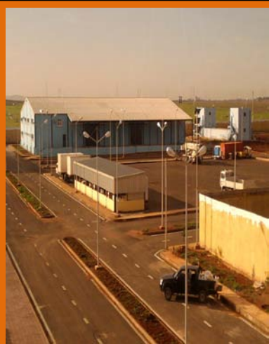
Réalisation Hangar, Abris et Aménagement Extérieurs
