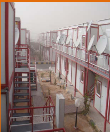
Réalisation d'une Base de Vie en R+1 et aménagement Ext
