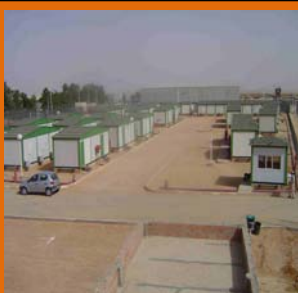
Réalisation Base de vie
