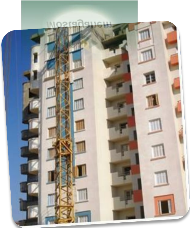
Bloc de 20 logements en R + 10
