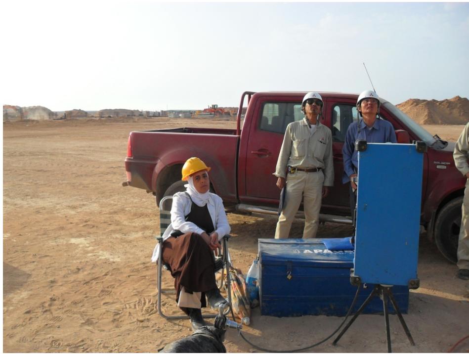
ESSAIS PRESSIOMETRIQUES USINE D'AMMONIAC ARZEW /MITSUBISHI
