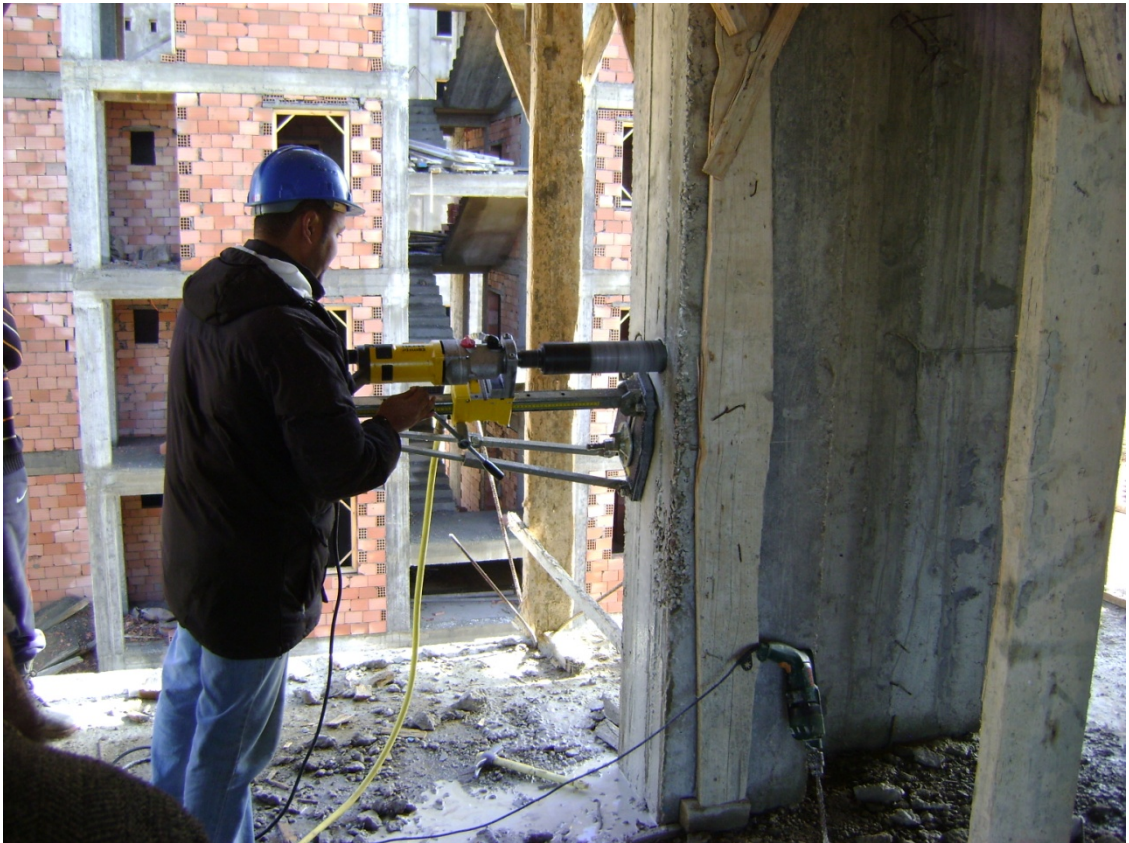
CAROTTAGE SUR BETON
