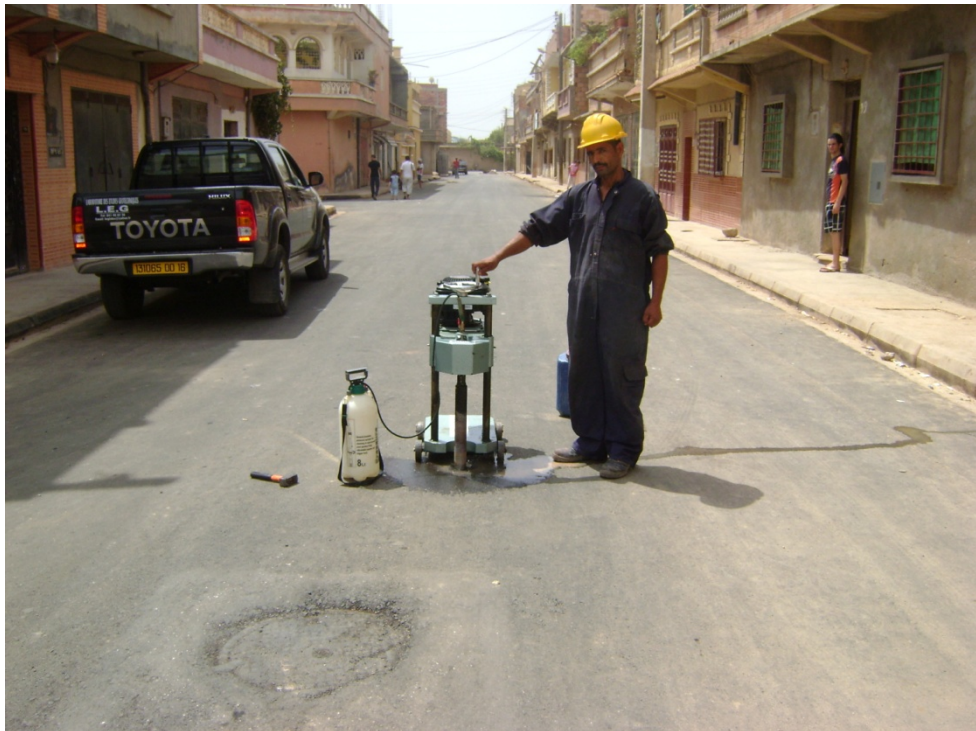
CAROTTAGE SUR BITUME
