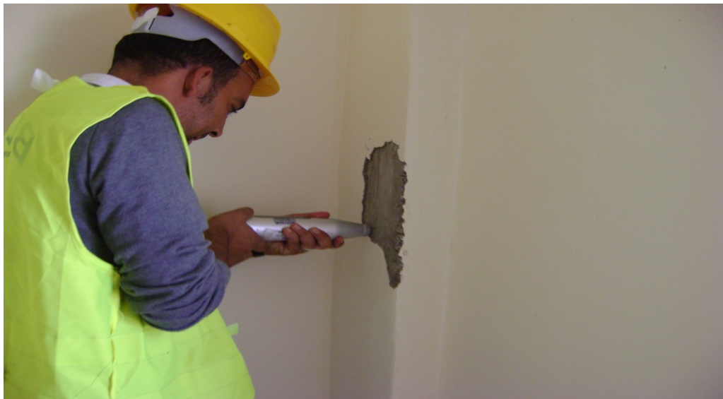
ESSAIS SCLEROMETRIQUES SUR BETON
