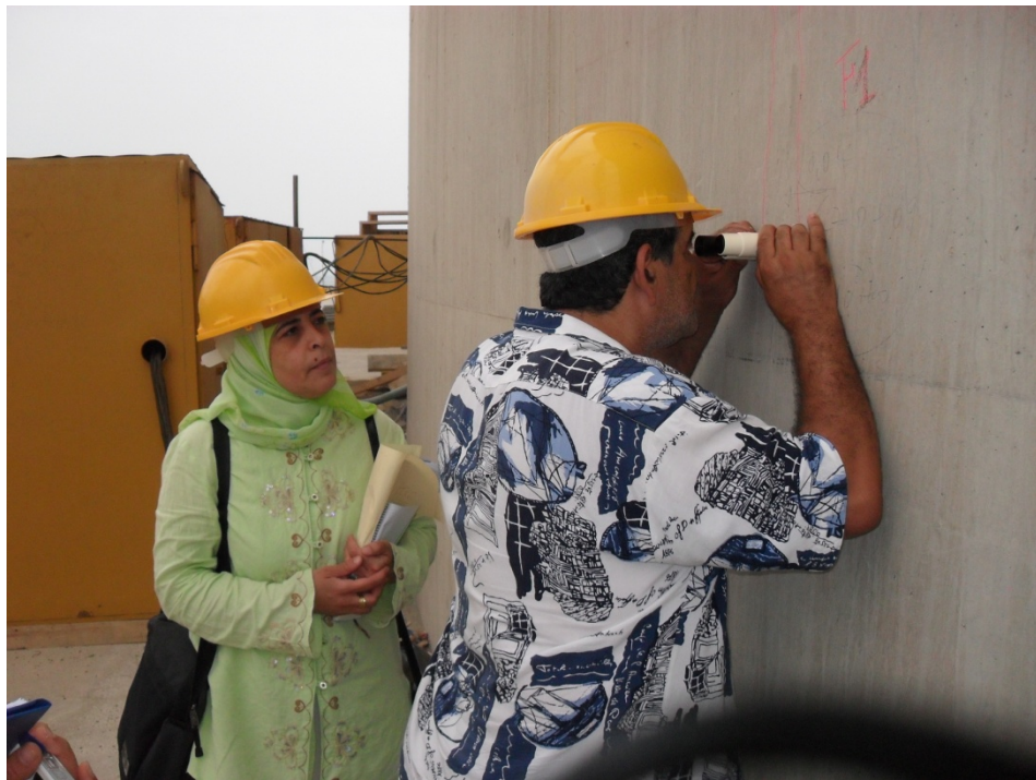
ESSAIS SUR BETON AU FISSUOMETRE BAC BUTANE ARZEW /BENTINI
